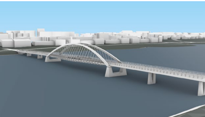
Skiss från alternativutredning - dubbelbåge som ansluter i höjd med brobana - vald inriktning
