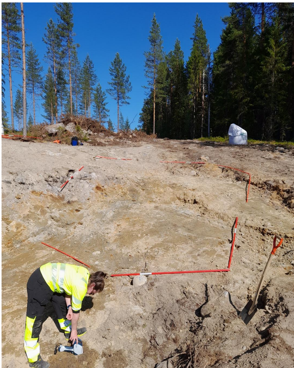
Figur 3. XRF-mätning under sanering 250711.
