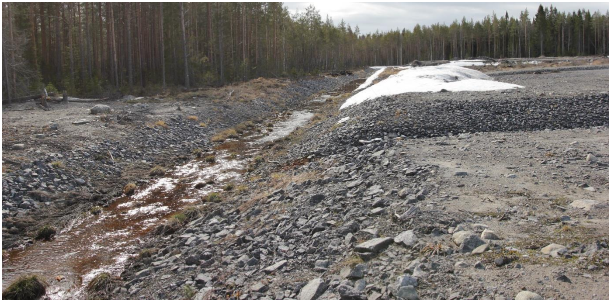
Figur 30. Punkt 10c. Dike nedströms pumpstation. Låg vattennivå.
