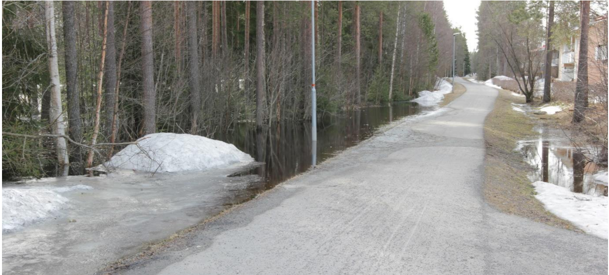
Figur 21. Punkt 3. Stående vatten mellan gångbana och Kolbäcksvägen vid korsningen Mjölkvägen/Kolbäcksvägen.
