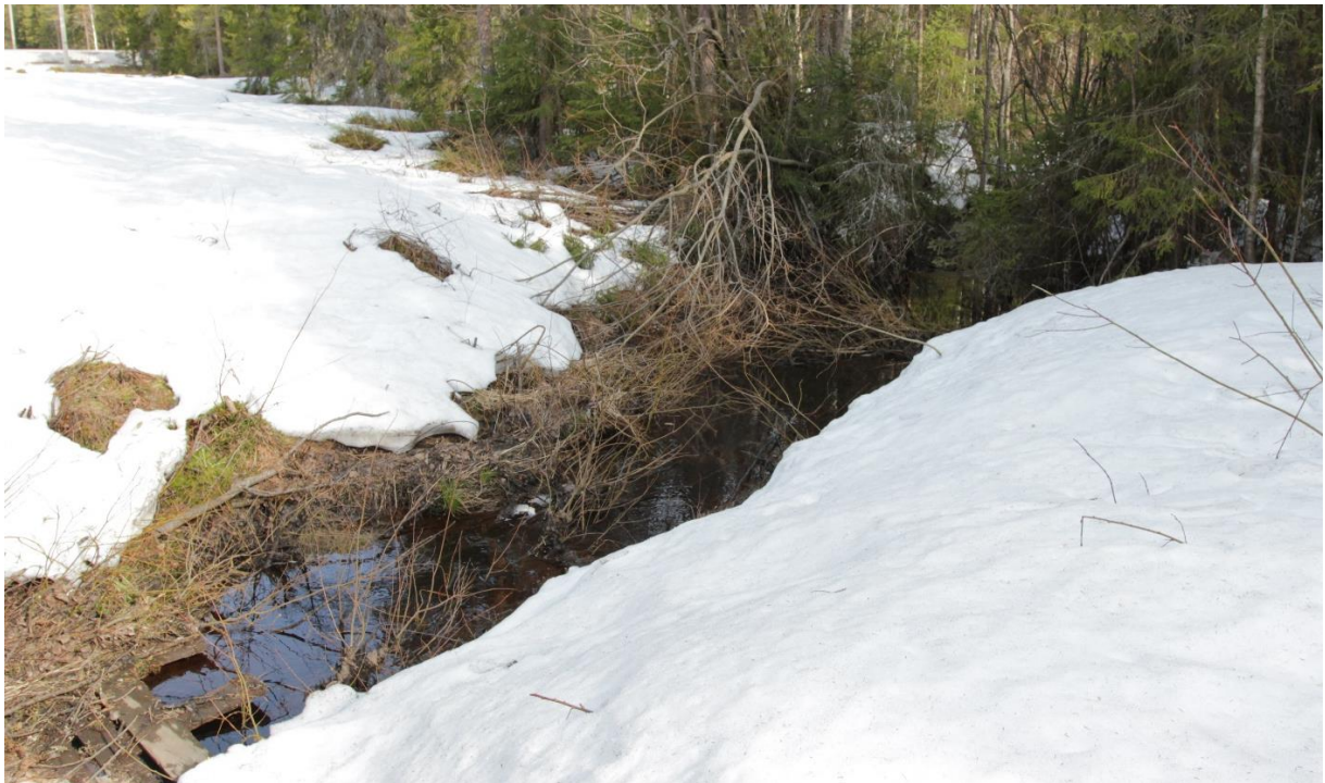
Figur 27. Punkt 9. Västra diket som leder dagvattnet från befintligt bostadsområdet genom utredningsområdet. Lugnt rinnande.
