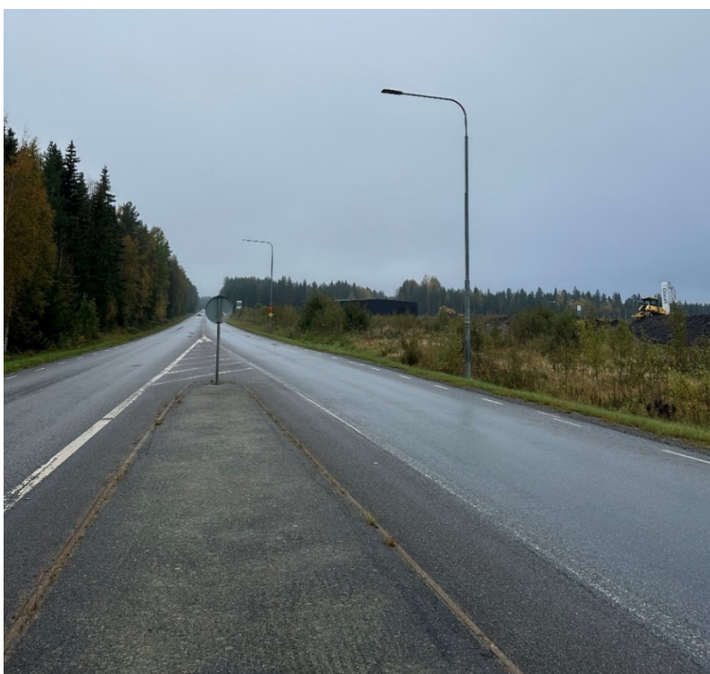
Figur 8. Fotografi från korsningspunkt Cementvägen/Kolbäcksvägen sett norrut. Etapp 1 till höger i bild, samt planområdet norröver.
