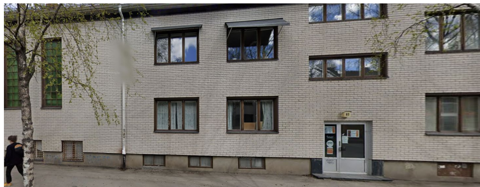
Figur 3 Kungsgatan 83. Google streetview
